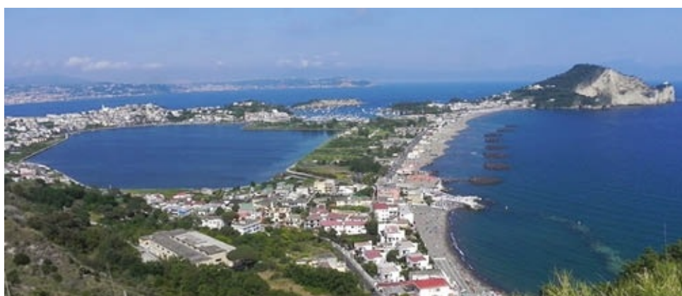
Aspecto actual del puerto de Miseno, al abrigo del promontorio de este nombre. Se dragó una dársena interior o mare morto , el lago Lucrino, que se aprecia en la fotografía. Los romanos tuvieron también la habilidad de dejar una amplia manga de arena como dique de abrigo exterior, la playa de Miliscola, separando el lago del puerto mediante los correspondientes diques y contradiques.
